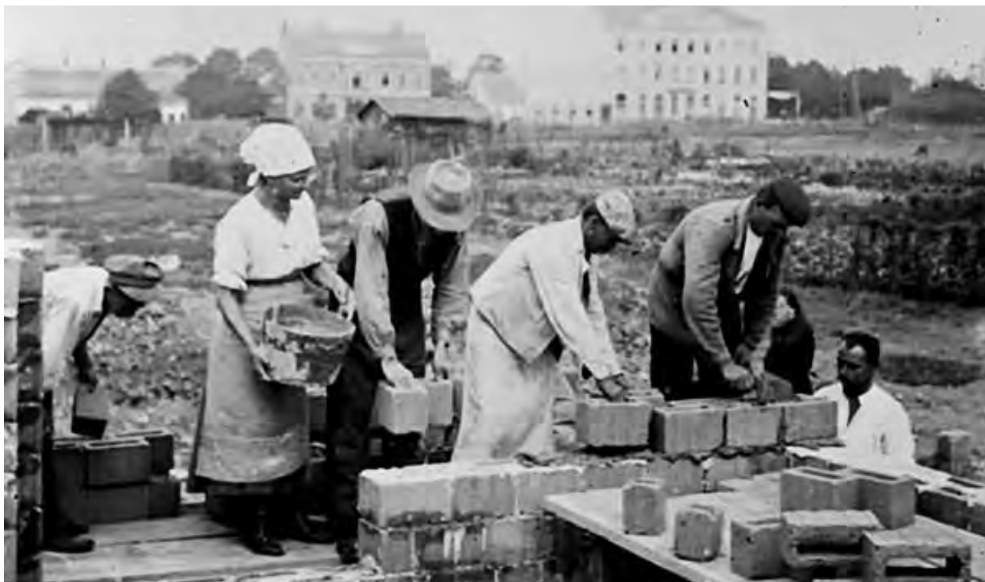
Fig. 8 Treballs de construcció dels habitatges socials a mans dels futurs habitants. Font: AH! Siedlung Rosenhügel.
